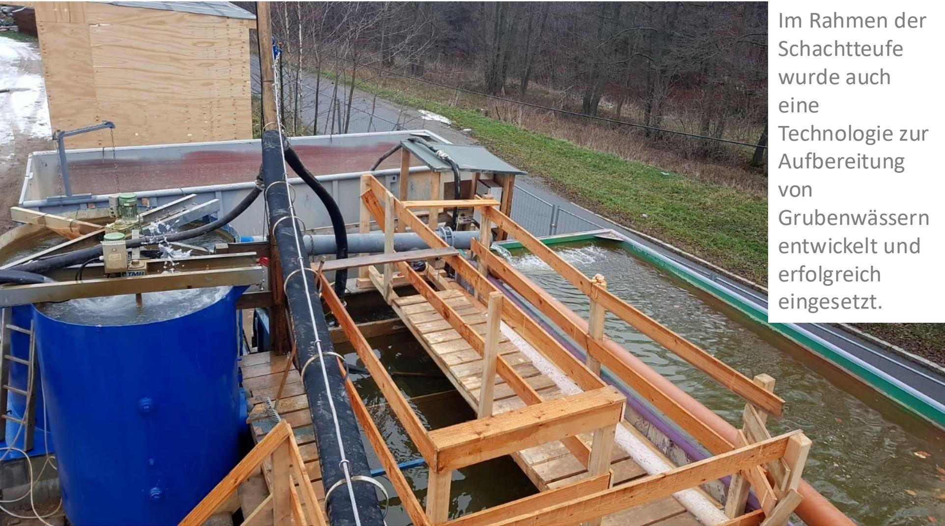
Im Rahmen der Schachtteufe wurde auch eine Technologie zur Aufbereitung von Grubenwässern entwickelt und erfolgreich eingesetzt.
