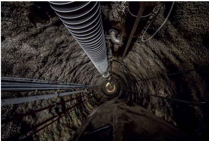
Bild 4: Blick in den ausgebauten Schacht
