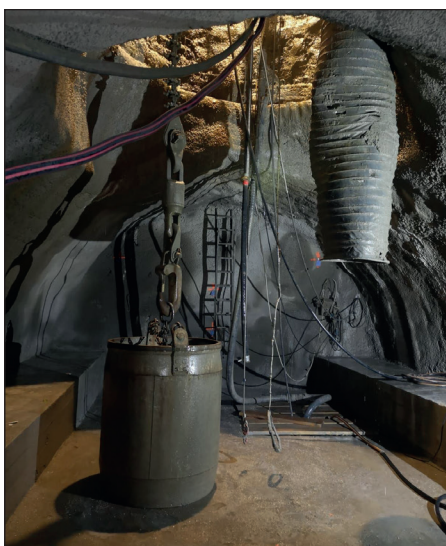
Bild 7: Füllort bei Endteufe
