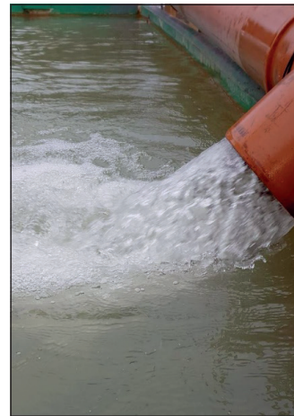
Bild 5: Rohwasser aus dem Schacht
